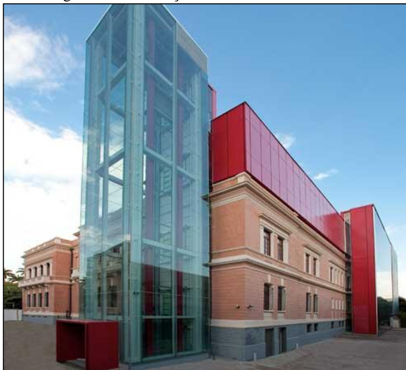
Figura 5 - Intervenções externas no Prédio Rosa
