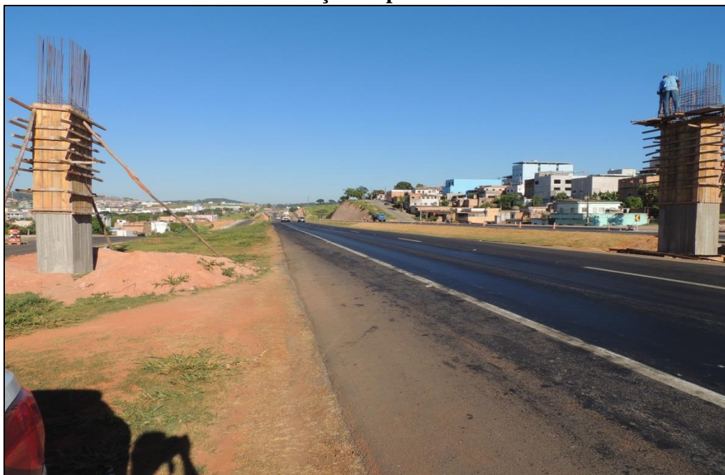
Foto 11 - Construção de passarela na BR 262
