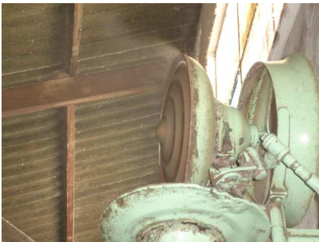
Sistema de aspersores Conhecido pelos trabalhadores como “ventilador de água”. Fonte: acervo pessoal
