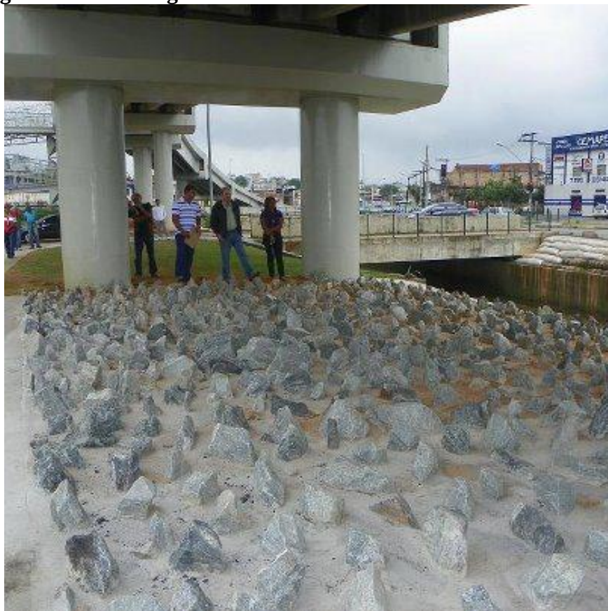
Figura 49 – Pedras gnaiss instaladas sob viaduto em Belo Horizonte
