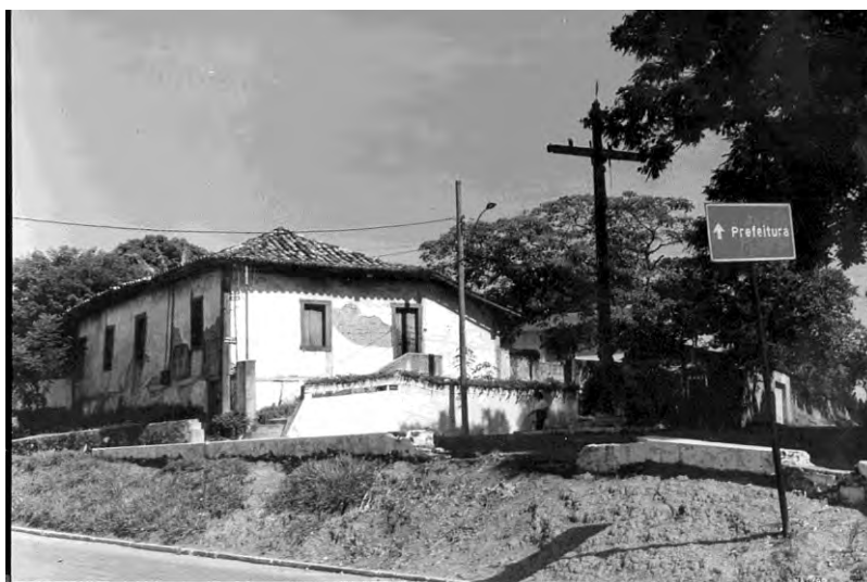
Figura 4 - Casa da Cultura antes da restauração e do tombamento. Acervo Casa da Cultura Nair Mendes Moreira - MHC.
