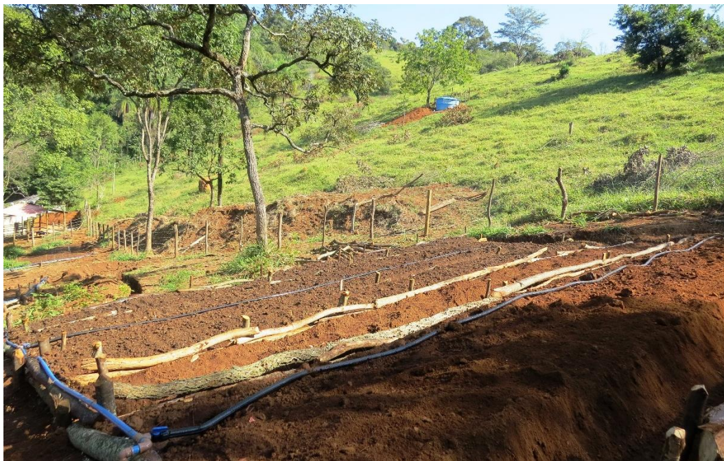
Foto 6.2 – Fase de construção da unidade experimental CSA da RMBH
