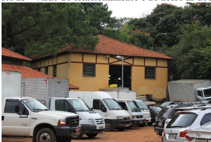
Foto 23 - Visão do estacionamento e do acesso às docas
